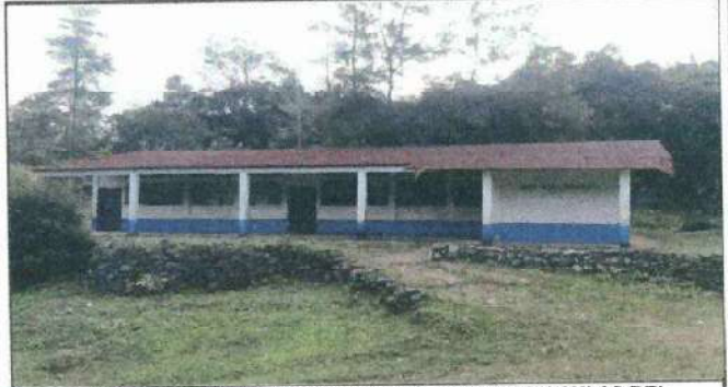
Foto 2: SUSTITUCION DE LAMINAS EN MAL ESTADO EN AULAS DEL MODULO 1
