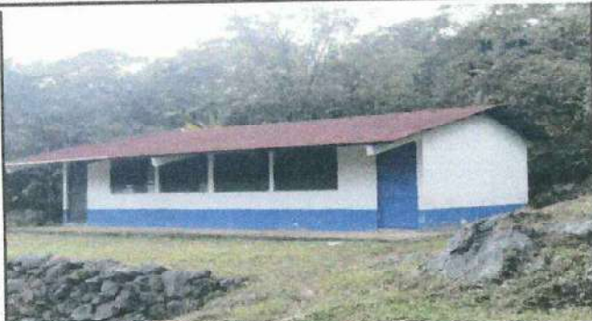
Foto 1: SUSTITUCION DE LAMINAS EN MAL ESTADO EN AULAS DEL MODULO 2
