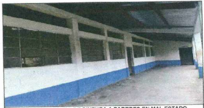
Foto 6: MANTENIMIENTO DE PINTURA A PAREDES EN MAL ESTADO
