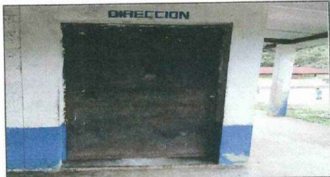
Foto 4: SUSTITUCION DE PUERTAS DE METAL YA QUE SE ENCUENTRAN EN MAL ESTADO
